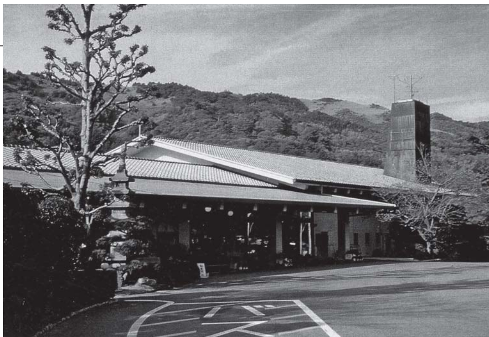
完成した玄関前
