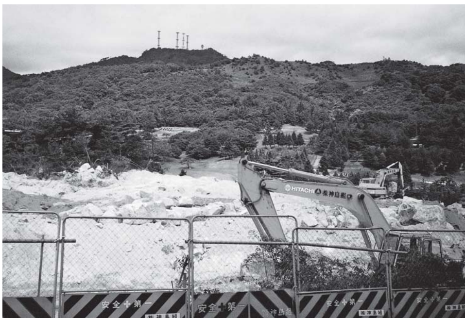
新駐車場工事開始
