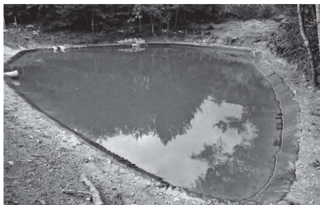
8番ホール横 水源池完成(散水用)
