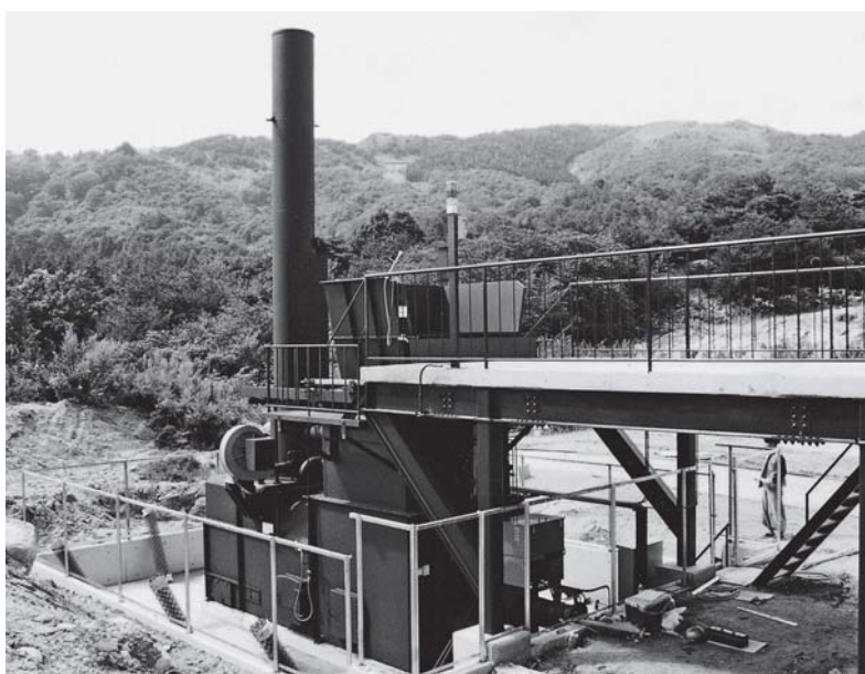
焼却炉の建設工事（4番ホール北のストックヤードにて）
