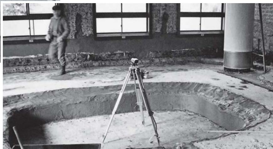
男子大浴場の改修工事
