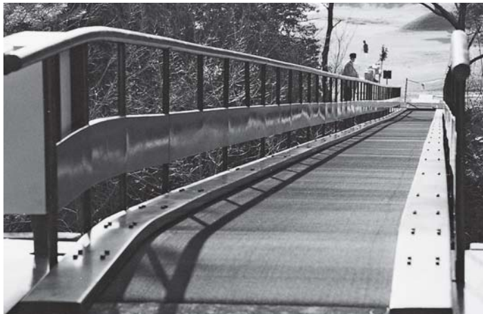
▲16番から17番へのマン・ベルトコンベア完成
