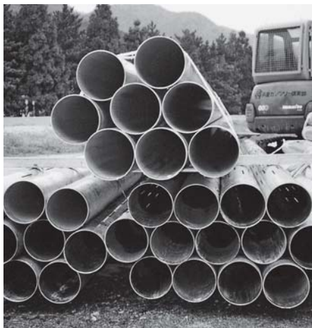
井戸掘削工事 深度500m 日/100t成功 (8番右グリーン上)
