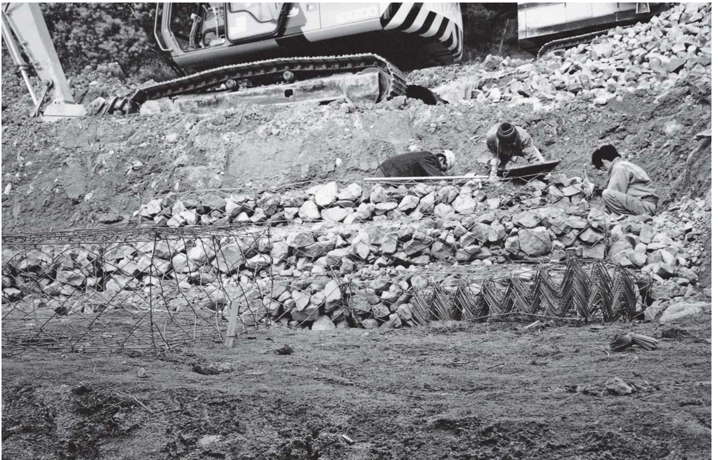
12番ホール左側、地滑り修復工事が急ピッチで進む
