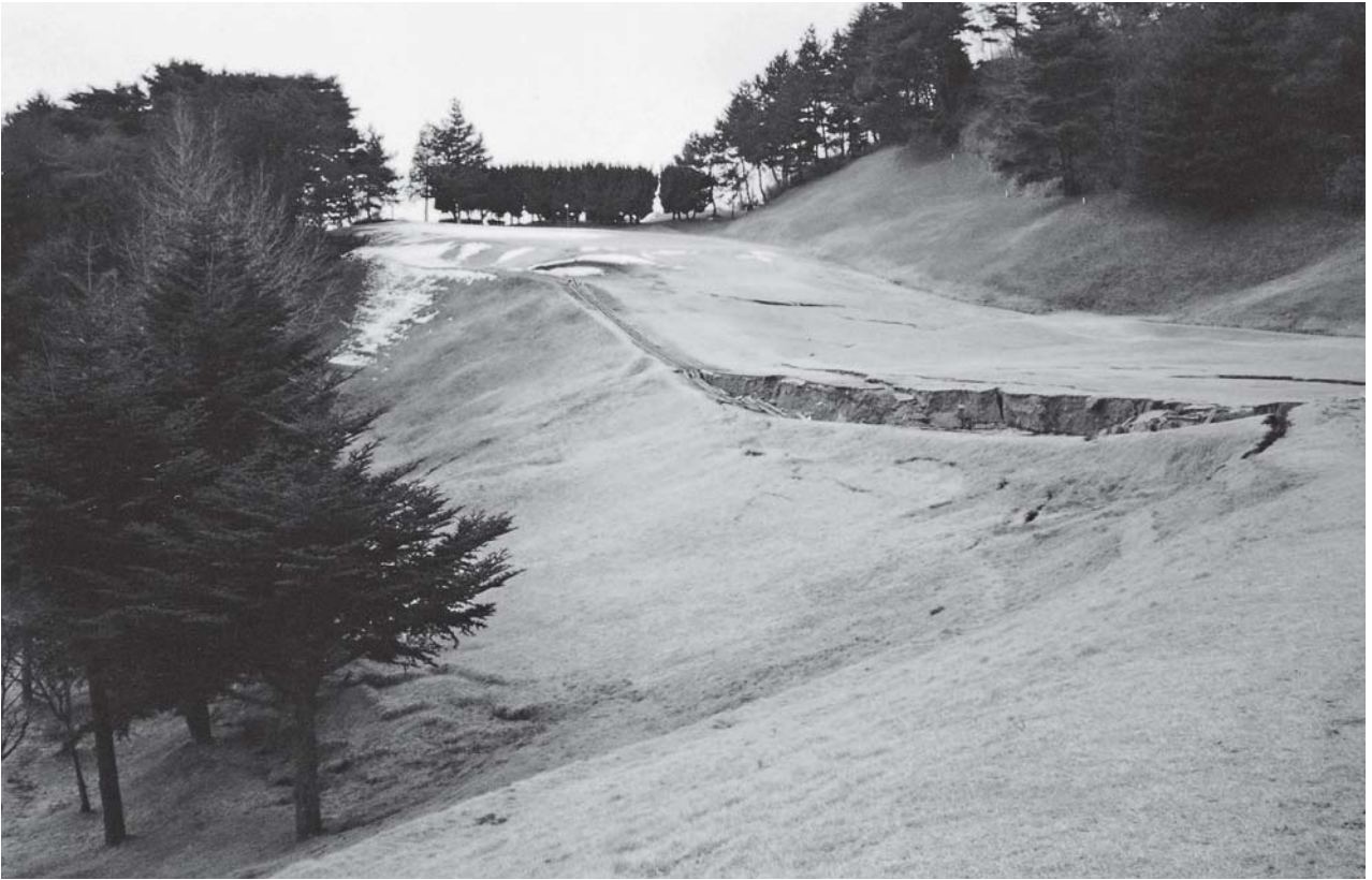
阪神大震災により、12番左に大地滑り発生
