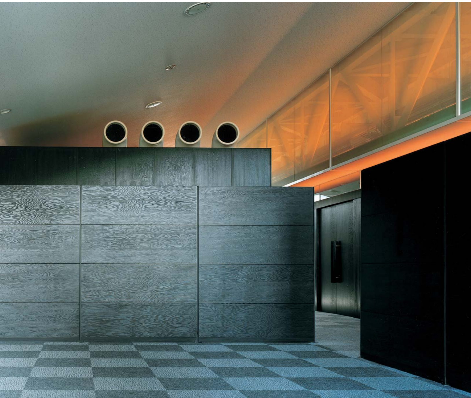
▲コンペルームの一室で木造の壁や衝立は、本館食堂と同じ松のベニヤ板を利用し、黒褐色で統一してある。写真右上がガラス箱内のキールトラス。
