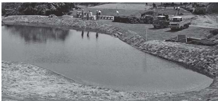
2番ティグラウンド前池工事
